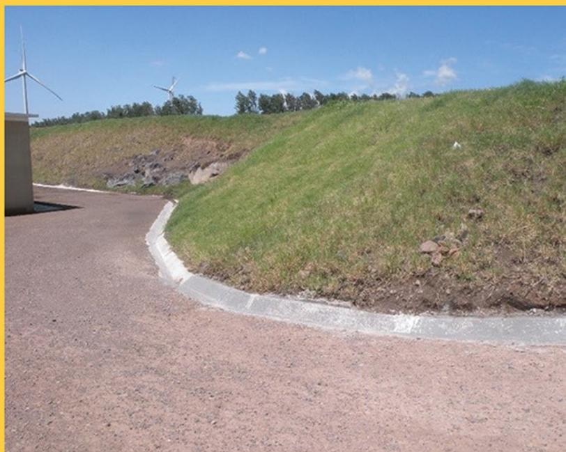
Talud del corte área de la sub estación eléctrica parque eólico San Antonio el Sitio, antes de ser revegetado y después de ser revegetado con grama local, para protegerlo contra la erosión. Obra de GES-VESTAS.
